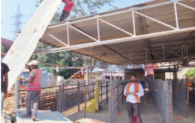
క్యూరైన్ షెడ్యు పనులు పర్యవేక్షిస్తున్న చైర్మన్, ఆశీర్వాచన మండపంలో రాష్ట్ర మంత్రి ఉషశ్రీచంద్
